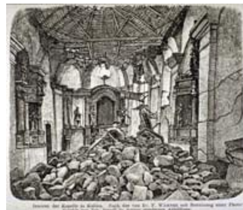
Porušena crkva u Kašini nakon potresa u Zagrebu 1880. (rekonstrukcija Franz Wähner, 1883.)
