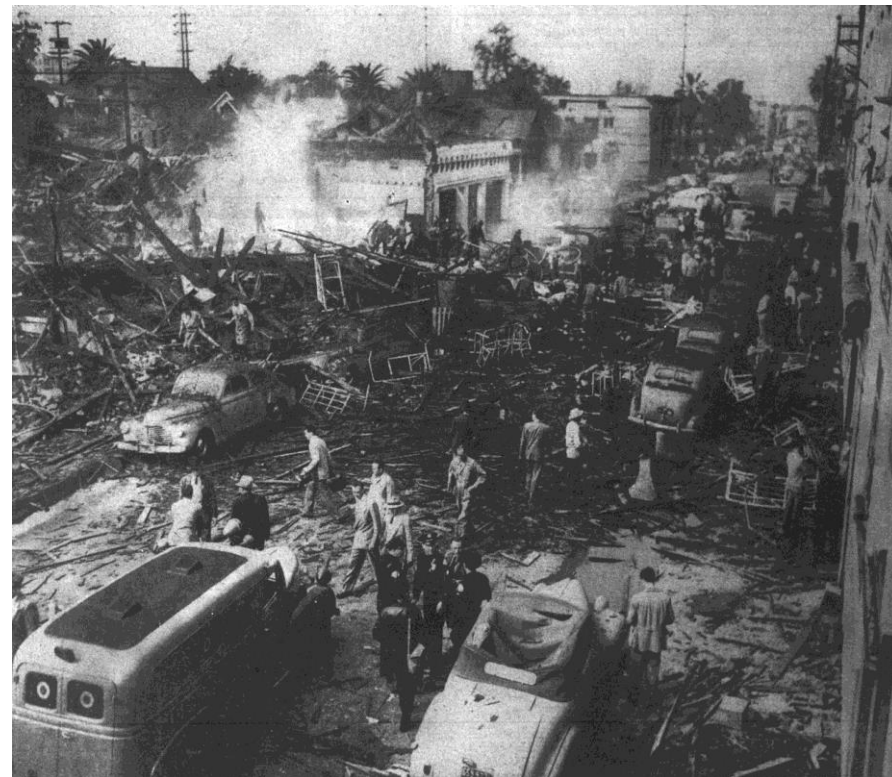
O'Connor Plating Works, Los Angeles, 1947. nakon eksplozije 500-litrene kupelji za elektrokemijsko poliranje aluminija (perklorna kiselina : acentanhidrid, 75:25), u koju je (zabunom) bila uronjena plastificirana polica.
