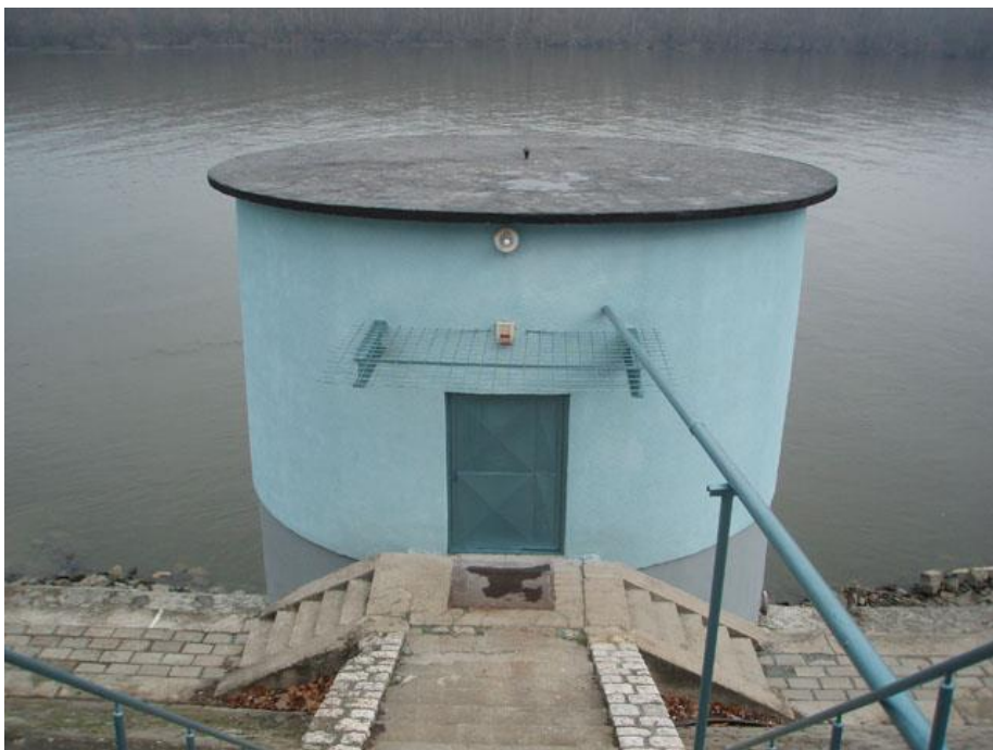
Vodozahvat na Dunavu, Vukovarski vodovod
