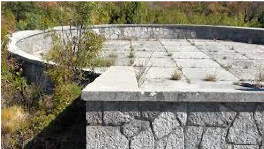
Šterna iz 1943. iznad Jurjeva s okruglom nakapnom površinom
