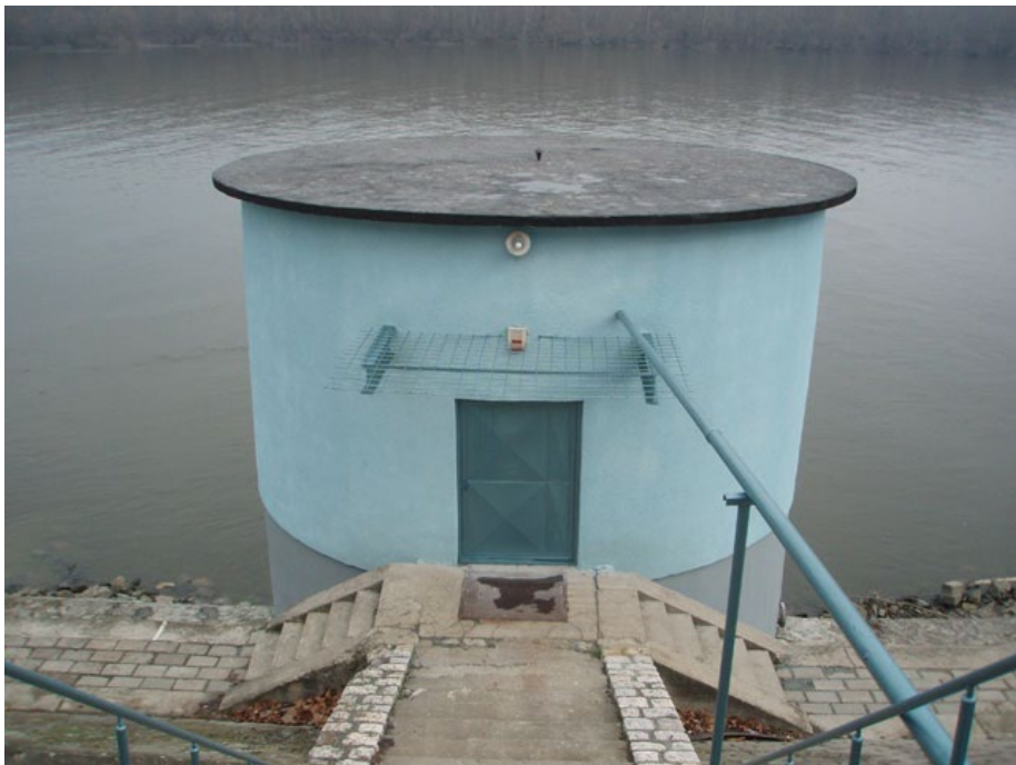
Vodozahvat na Dunavu, Vukovarski vodovod
