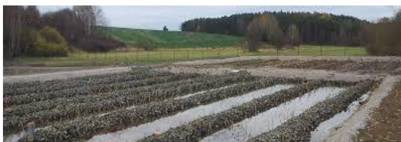
SLIKA 2. Međusobno povezani bazeni kod površinskih biljnih uređaja [10]
