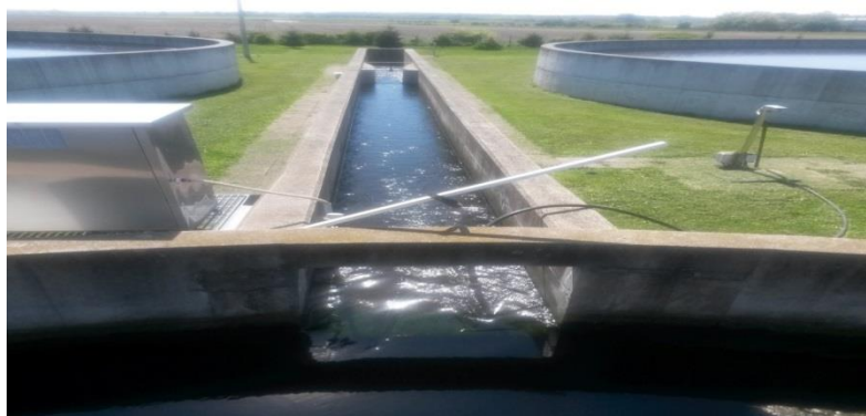
Slika 2. Ispust u Venturijev kanal UPOV „Jošine“ Fig. 2. Venturi flume in wastewater treatment plant “Jošine”
