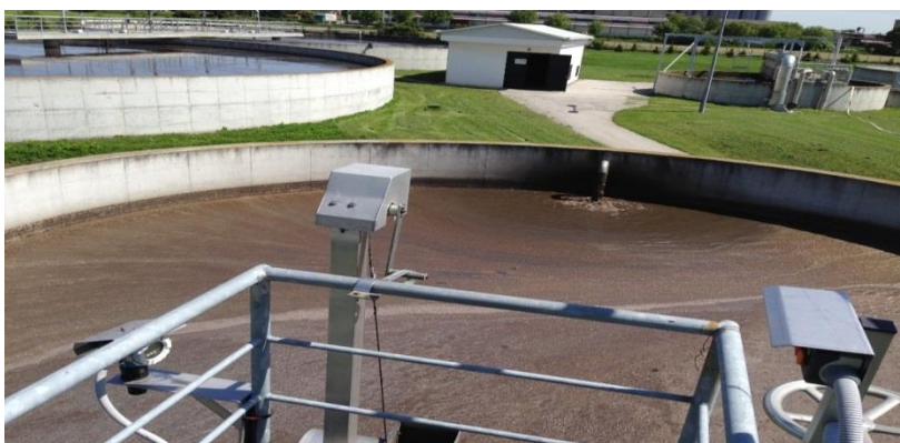
Slika 3. Ugušćivač mulja UPOV „Jošine“
