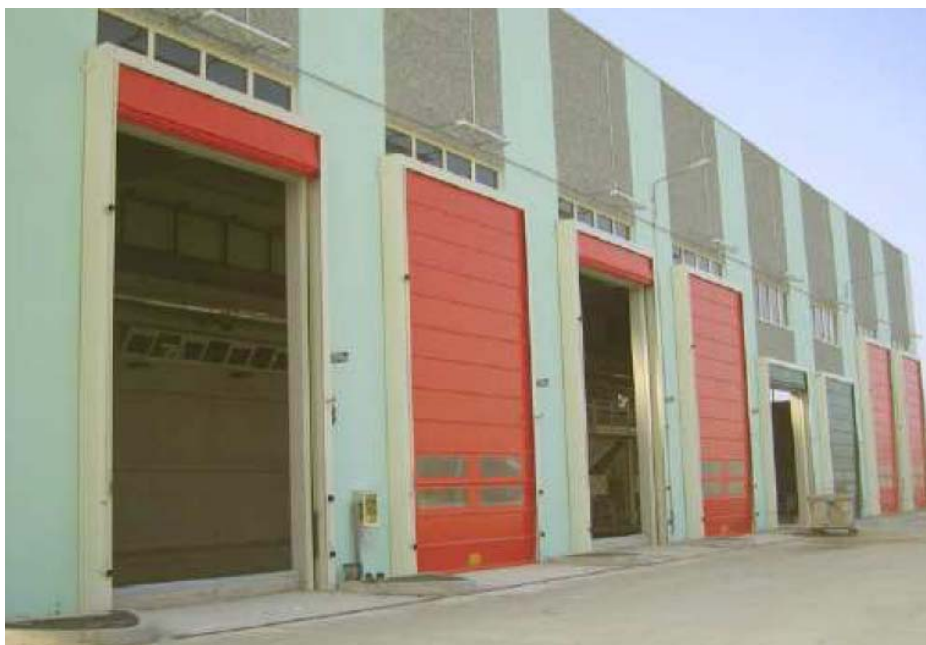
Slika 1.2.1./1 Rolo vrata prijemne jame za prihvata otpada u MBO postrojenje.
