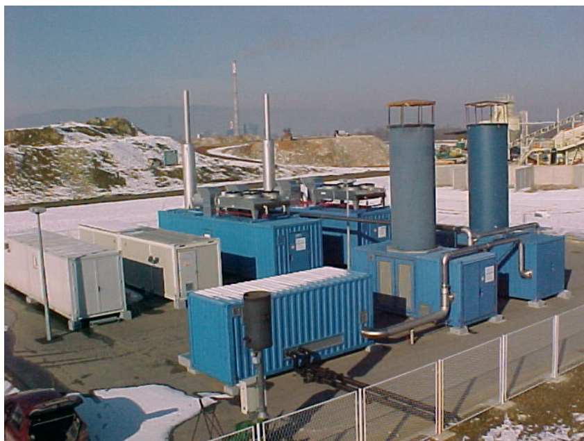
Slika 1.2.4./2 Postrojenje za obradu bioplina i/ili proizvodnju električne energije iz bioplina
