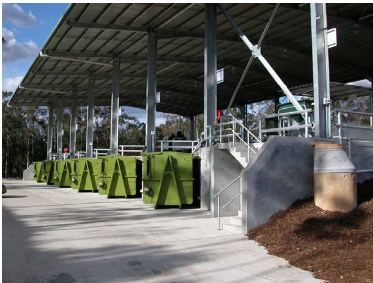
Slika 1.2.7./1 Plato za sekundarne sirovine (primjer izvedbe s nadstrešnicom)
