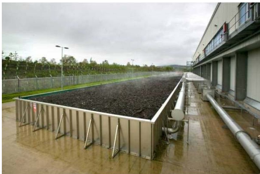
Slika 1.2.2./4 Biofilter za obradu ispušnog zraka sa prijema otpada, predobrade i biosušenja.
